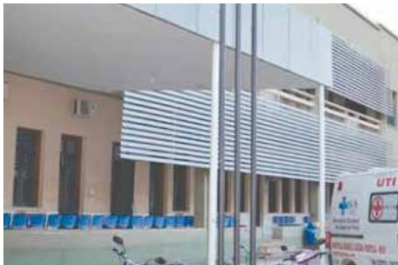
Fachada do Hospital Infantil, que enfrenta problemas, principalmente na UTI
